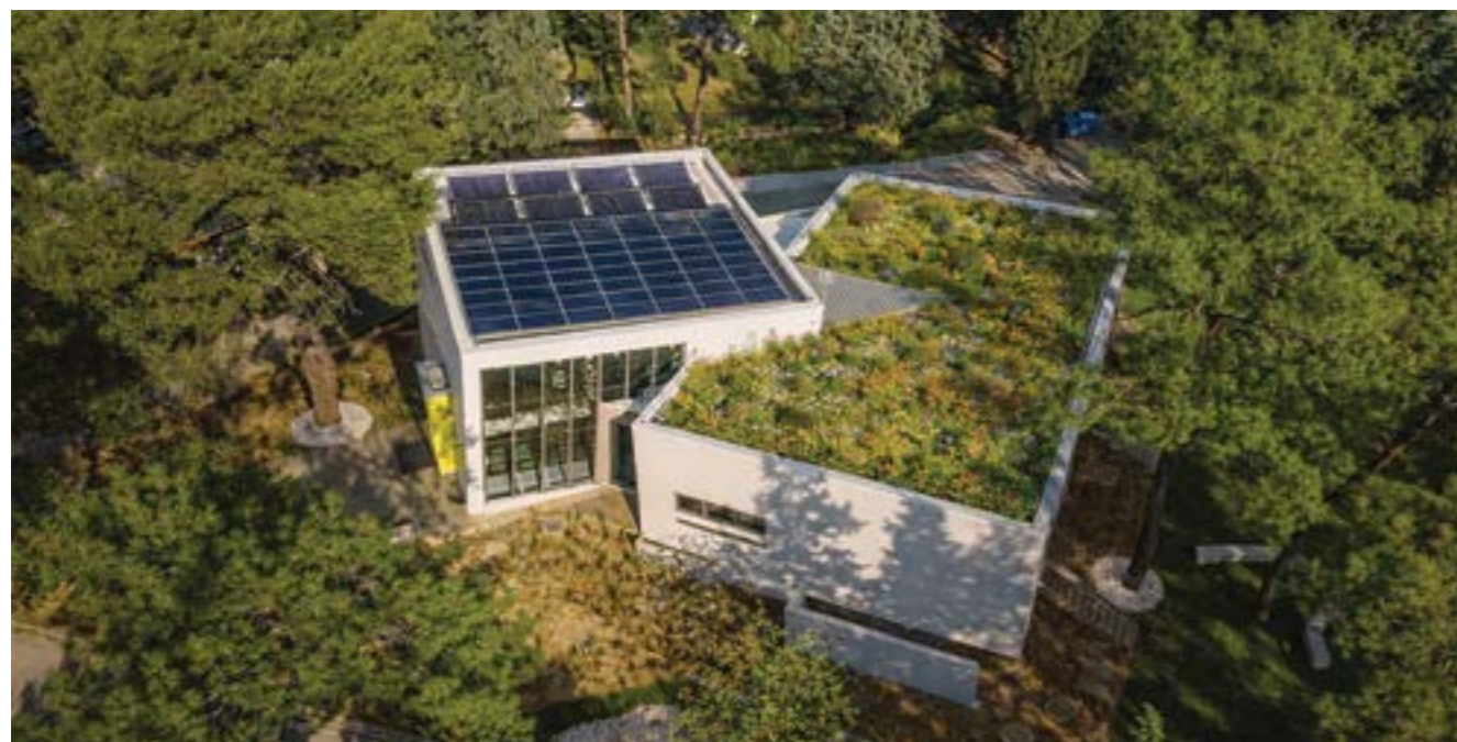
Το φυτεμένο δώμα και τα φωτοβολταϊκά πετάσματα συμβάλλουν στην ενεργειακή συμπεριφορά του κτιρίου.
