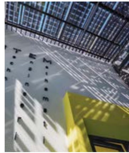
Οι περσίδες κάτω από την οροφή λειτουργούν ως σύστημα σκίασης και διάχυσης του φυσικού φωτός.
